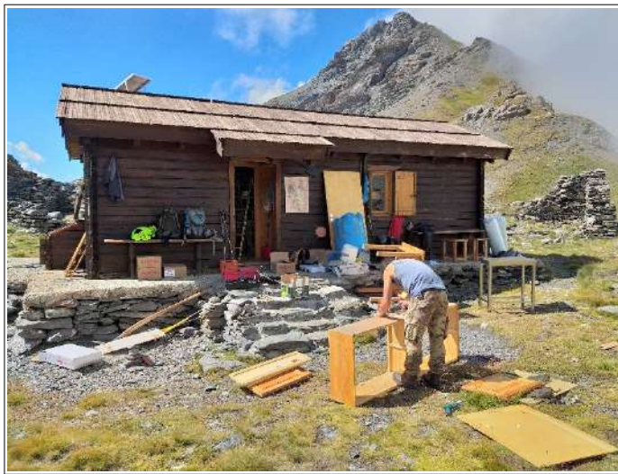
Lavori ignifugazione del bivacco del Colle del Beth. - Foto A. Meirone
