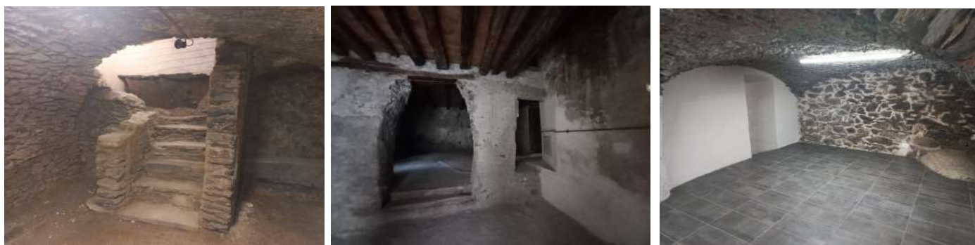
Hotel Dieu - Fine lavori finanziati dal PSR(Misura 764) – locale cantina, ingresso vicolo, locale ex stalla. - Foto Nadia Faure
