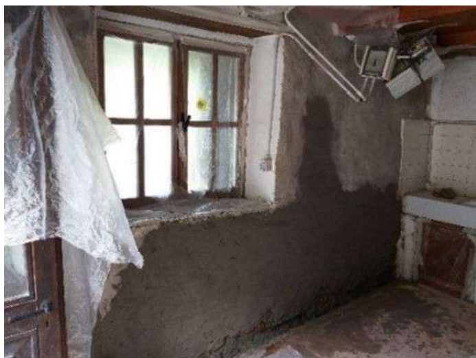
Manutenzione del Baracot d'la poump. Prima dell'intervento.- Foto A. Meirone
