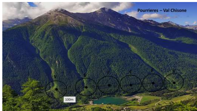
Punti di ascolto alla base di canali da valanga.- Foto Arch. DBios
