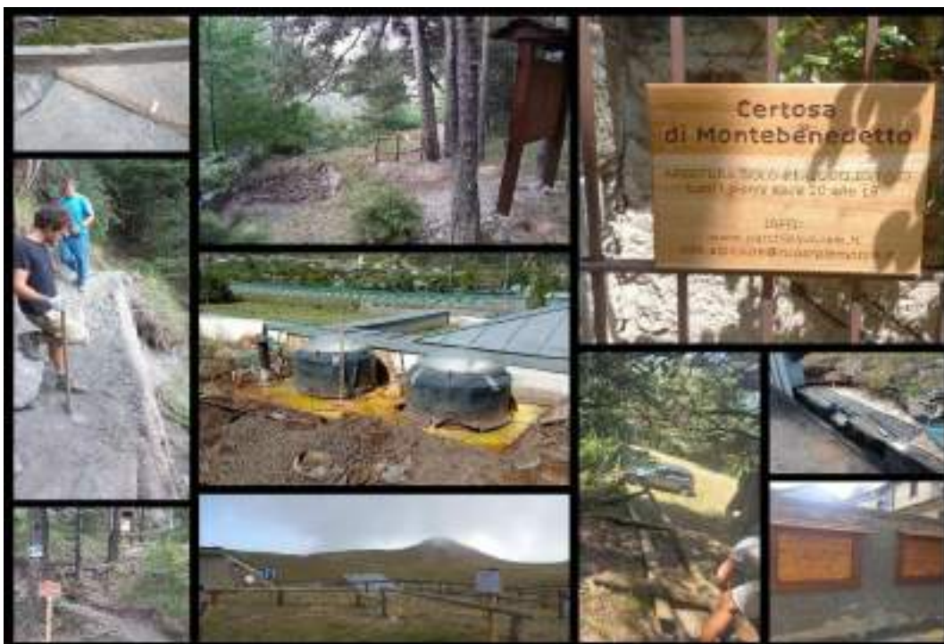
Interventi vari di manutenzione immobili e infrastrutture.- Foto Arch. EGAPAC
