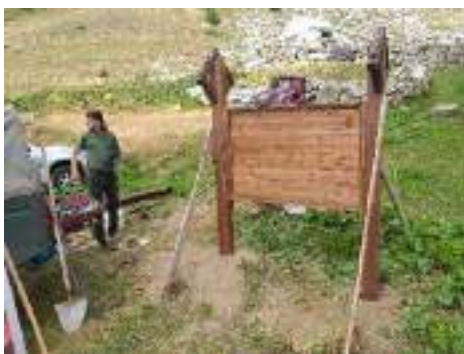
Rifacimento tettuccio edicole PNV.- Foto Arch. EGAPAC
