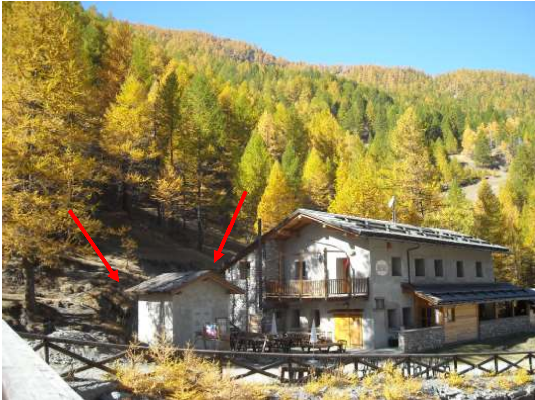
Mulino di Laval – vista del sito di intervento
