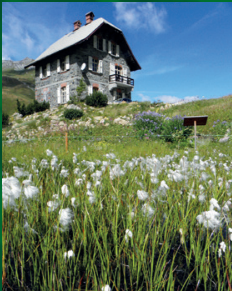
Edificio principale del Giardino La Chanousia che ospita il personale e eventuali studenti, le attrezzature e il materiale e una piccola biblioteca. In primo piano stazione di Eriophorum .
