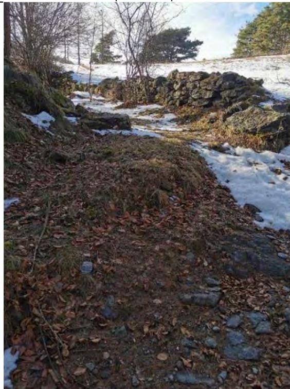
Foto 12: Ripresa del piano di calpestio da regolarizzare e in cui è previsto lo spandimento di misto stabilizzato
