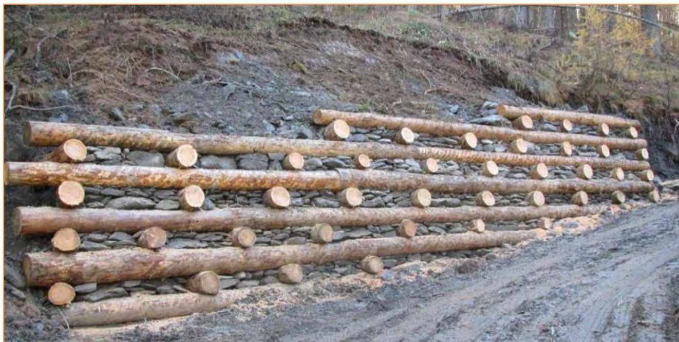
Immagine indicativa della sistemazione delle pietre a vista nel fronte della palificata
