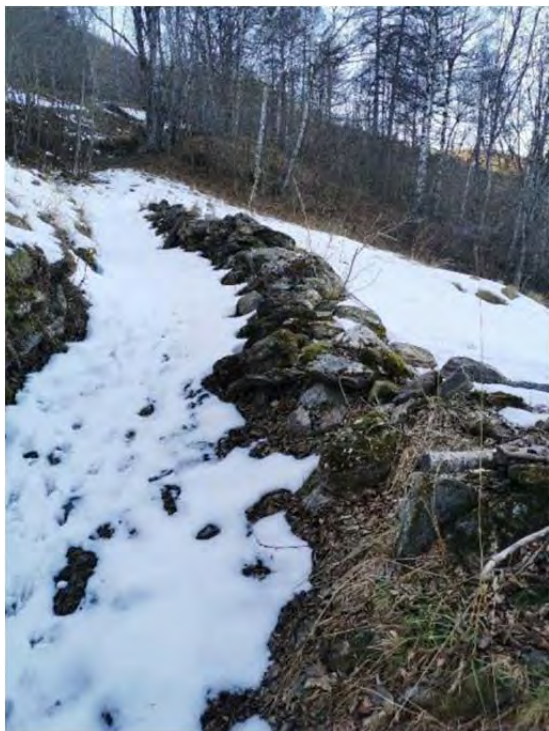
Fig.9: Ripresa di un muretto a secco da ricostruire
