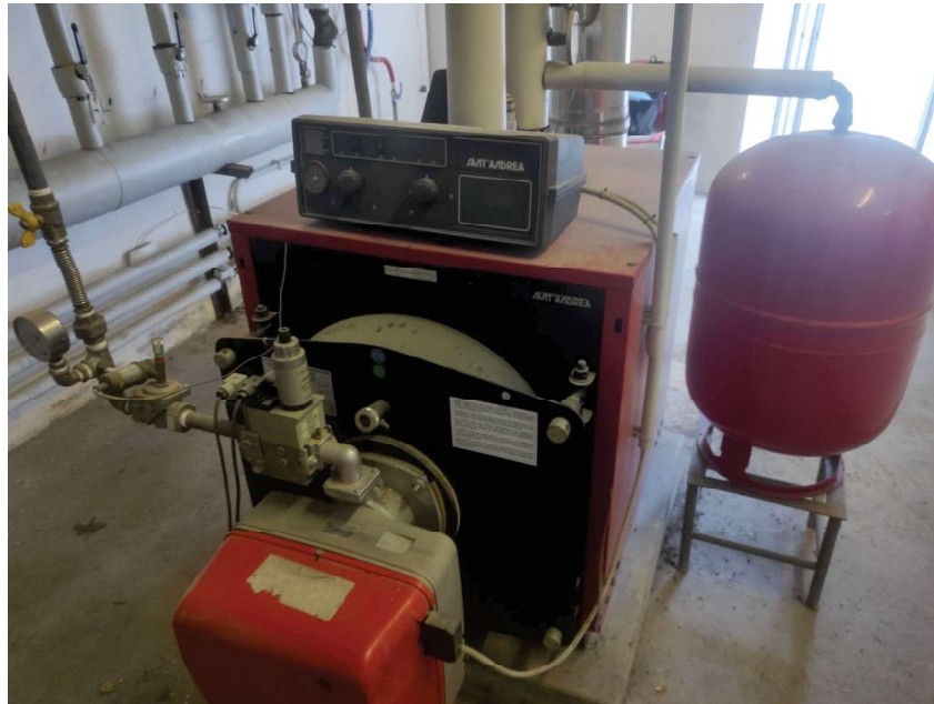
Foto n. 1: generatore di calore esistente da sostituire
