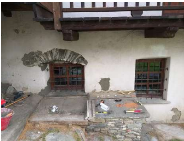
Installazione inferriate presso Casa Escartons. Foto Archivio EGAPAC
