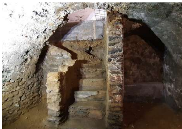
Dopo la rimozione dei cumuli di pietra. Foto Archivio EGAPAC
