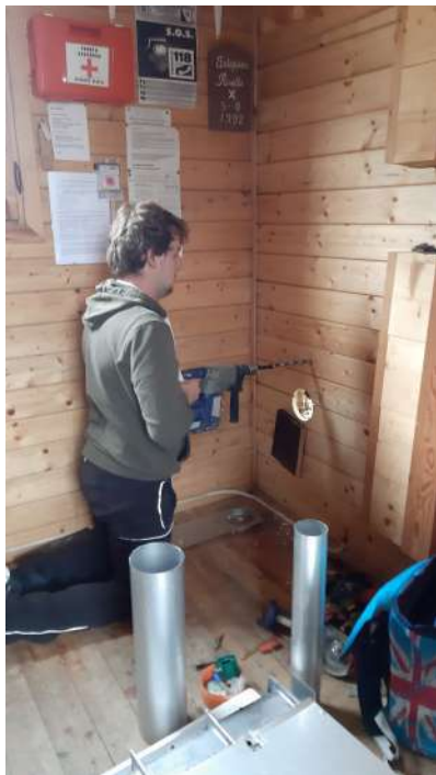
Sostituzione stufe rifugi non gestiti. Foto Archivio EGAPAC
