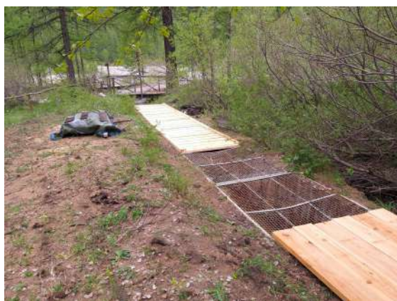
Rifacimento copertura canale di scolo laghetto Val Troncea. Archivio EGAPAC
