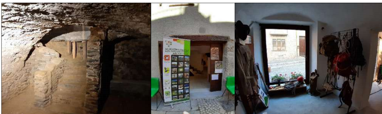
Hotel Dieu: ultimazione lavori di restauro e risanamento conservativo per la realizzazione di un punto informativo turistico – Programma di Sviluppo Rurale 2014-2020 mis.751 “Sostegno ad investimenti di fruizione pubblica in infrastrutture ricreative, inf. turistiche e infrastrutture turistiche su piccola scala”. Foto Archivio EGAPAC
