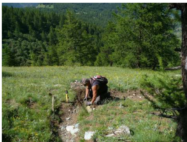
Pulizia canalette sentieri. Foto Archivio EGAPAC
