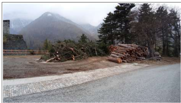
Interventi c/o forte di Fenestrelle. Foto Archivio EGAPAC
