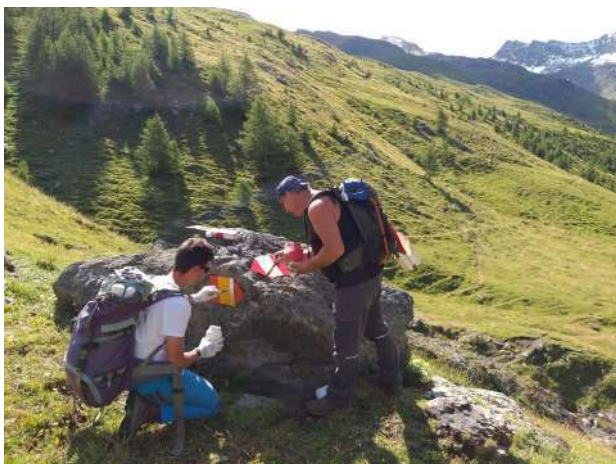
Rifacimento segnaletica orizzontale. Foto Archivio EGAPAC
