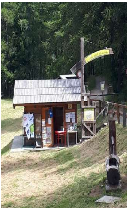
Lavori per i servizi igienici al punto informazioni di Ser Blanc. Foto arch. EGAPAC
