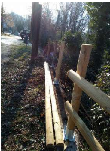
Sostituzione recinzioni ad Avigliana. Foto Arch. EGAPAC
