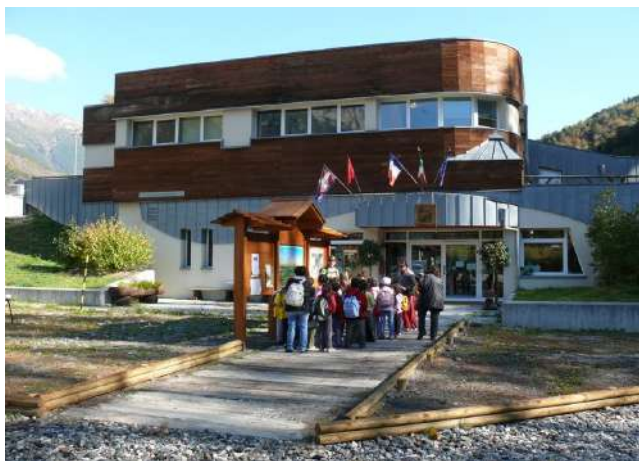
La Sede legale dell'Ente di gestione delle Aree protette delle Alpi Cozie ospita uffici tecnico amministrativi ed un centro visitatori. Foto Archivio EGAPAC
