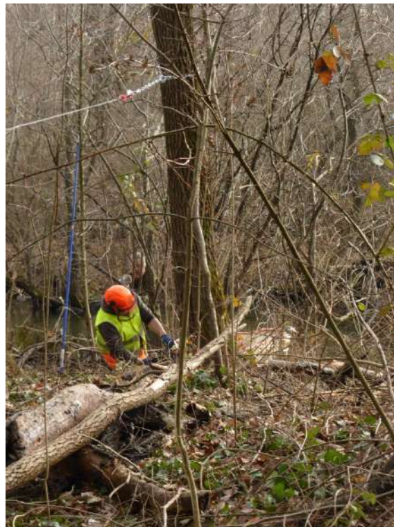
Ripristino deflusso del canale Naviglia ad Avigliana: ancoraggio del tronco e trasporto a riva con l'ausilio del verricello e successivo sezionamento. Foto arch. EGAPAC
