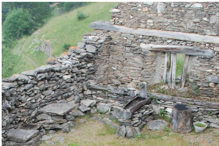
*Dettaglio dei due tipi di muratura e dell'apertura con architrave ligneo.*
