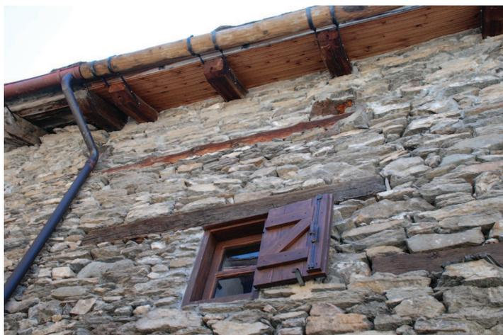
Dettaglio del fronte Ovest, travi inserite nella muratura e finestra lignea. Orditura lignea della copertura e gronda in legno con staffe metalliche.
