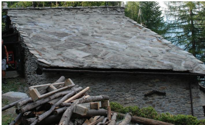
*Dettaglio del manto di copertura in lose cementate.*
