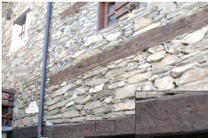
Fronte Ovest, travi inserite nella muratura e dettaglio dell'incisione su architrave in legno con data 1797.
