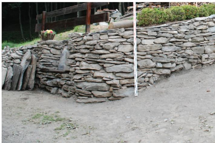
*Dettaglio della particella n.59, di cui sono ancora visibili porzioni di muratura in pietra a secco.*
