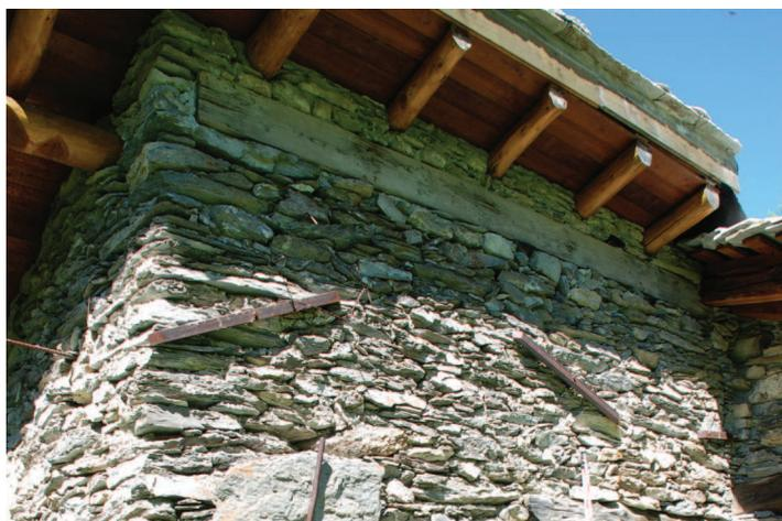
Fronte verso monte, dettaglio delle catene metalliche e aggiunta di muratura in pietra con cemento in prossimità della copertura.
