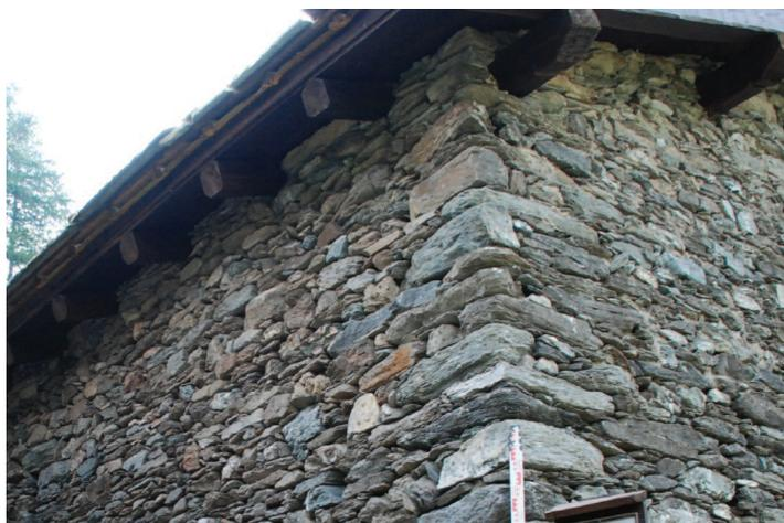
*Dettaglio della copertura restaurata, con travi nuovi e inserimento di lamiera grecata al di sotto del manto in lose. Dettaglio della muratura in pietra a secco e dei massi più grandi utilizzati nel cantone.*
