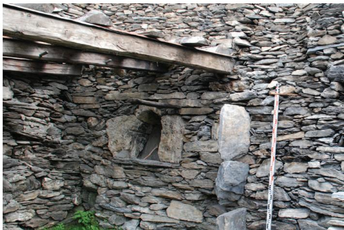
Vista dall'interno del rudere, nel dettaglio si nota una nicchia costituita da tre blocchi di pietra tufacea scolpita. In alto le travi residue di un solaio ligneo.
