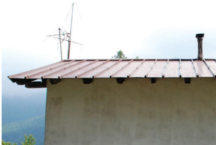
*Dettaglio della copertura con orditura lignea e manto in lamiera.*
