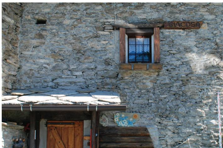
Fronte su strada, dettaglio di tettoia in legno e lose, pluviale metallico e finta cornice in legno della finestra.
