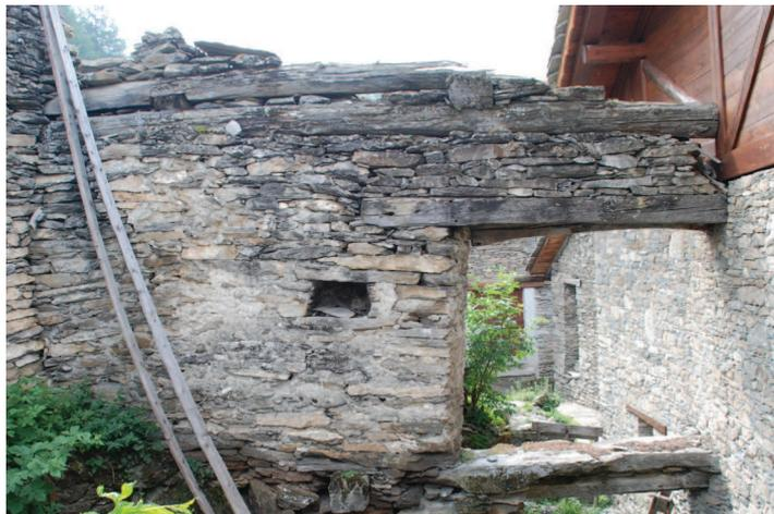
Dettaglio di una parete che presenta travi in legno inserite nella muratura. Aperture con architravi in legno, nicchia con architrave in pietra.
