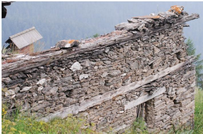
*Dettaglio delle travi in legno inserite nella muratura, sia all'esterno che all'interno.*
