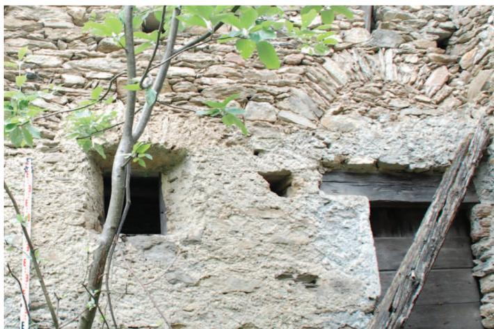
Fronte Nord - Ovest, dettaglio di porta con arco di scarico e architrave ligneo e finestra con piattabanda in conci di pietra.
