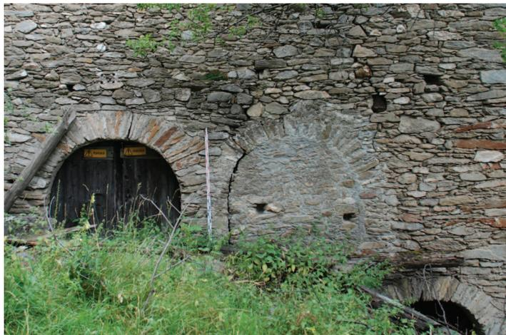
Dettaglio del fronte Nord, con tre aperture sormontate da archi in conci di pietra.
