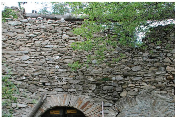
Dettaglio del grosso trave di colmo, che è ancora in posizione nonostante il collasso del resto della copertura.
