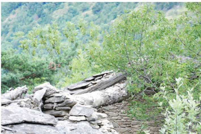
Dettaglio della copertura, il grosso trave di colmo è ancora in posizione nonostante il resto della copertura sia collassata.
