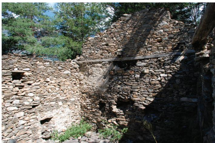
*Vista dall'interno, le pareti presentano delle travi in legno disposte orizzontalmente al fine di irrigidire la struttura muraria. La copertura risulta collassata e le pareti pericolanti.*
