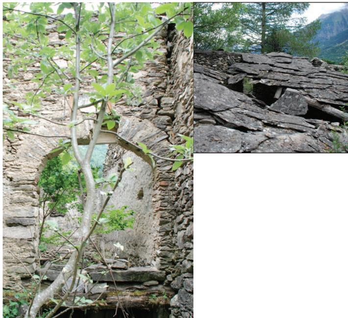
Dettaglio dell'arco in conci di pietra presente sul fronte Nord, con sopra data 1833 e dissesto del manto di copertura.
