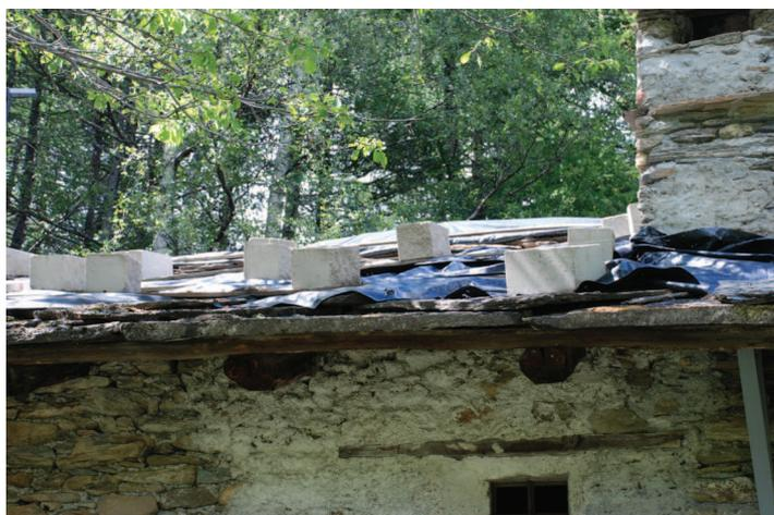
*La copertura si presenta in condizioni precarie, con teli e blocchi allo scopo di evitare temporaneamente infiltrazioni d'acqua, a causa di lacune nel manto di copertura in lose.*
