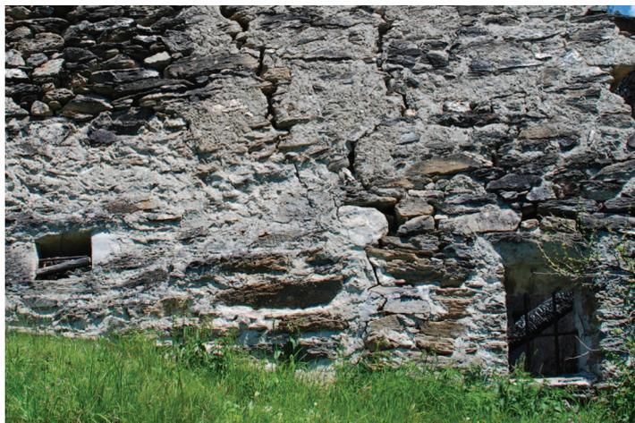
Dettaglio delle aperture sul fronte verso valle, prive di serramento ma dotate di grate in ferro. La finestra di destra presenta una strombatura sul lato superiore.
