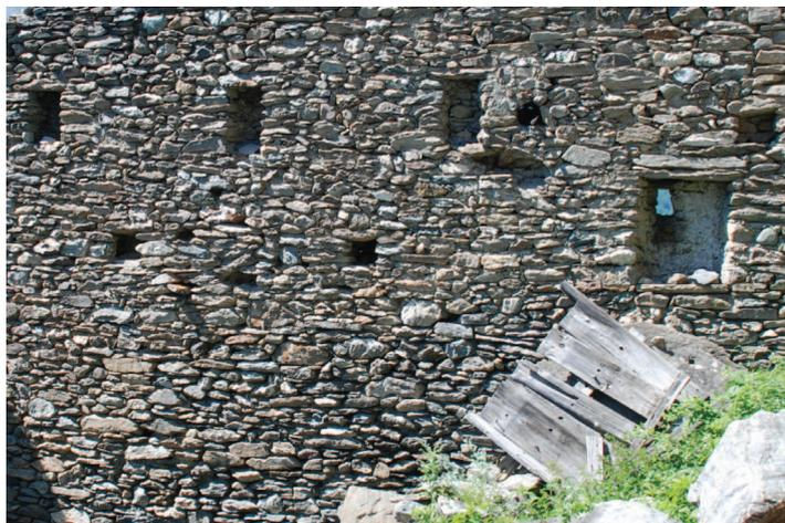
*Dettaglio delle aperture tamponate, di cui una solo in parte, del fronte Nord - Ovest. In basso a destra il portone in legno, e a perno in legno, a due ante.*
