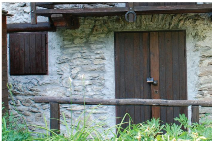
*Particolare delle aperture e dei serramenti. Le ante sono rivestire in legno ma con struttura metallica. Le nuove aperture sono state tamponate con malta grigia particolarmente visibile; è stato conservato l'arco di scarico in pietra. E' stato riproposto l'architrave in legno.*
