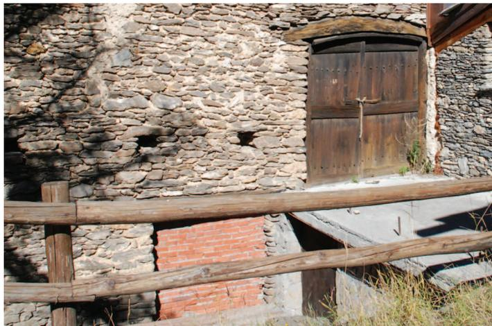
Fronte Nord, dettaglio del portone con architrave ligneo curvo. In basso apertura tamponata con laterizi e superfetazione in c.a. non completata.
