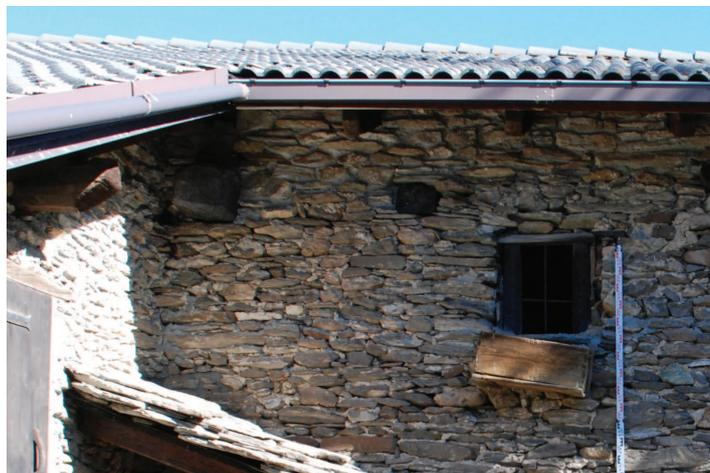
Dettaglio del manto di copertura in finto coppo. Al di sotto inserimento di muratura in pietra con cemento. Finestra originale con cornice lignea.
