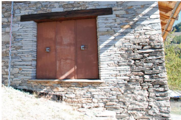
Dettaglio della parete Est, portone strombato con scuro metallico, Spigolo Sud con diversa tessitura muraria, probabilmente residuo originale.
