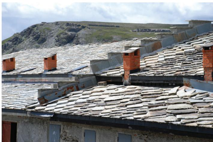
Dettaglio della copertura, non omogenea, e di alcune aperture con scuri metallici. Parete a gradini che fuoriesce dalla copertura.
