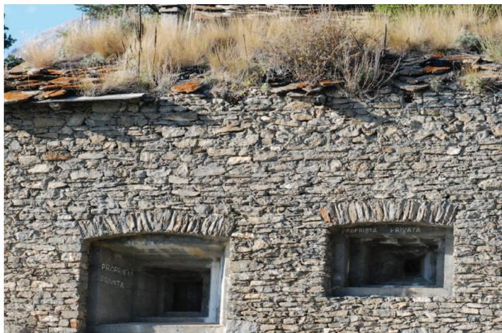
Dettaglio delle finestre strombate verso valle e della falda in lose con abbondante vegetazione.
