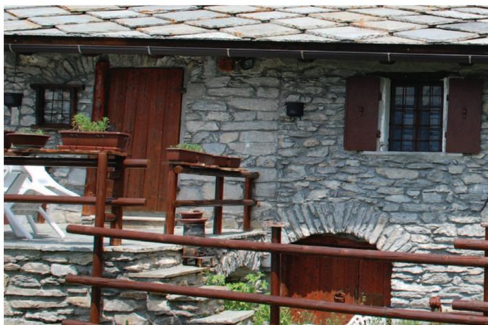
Dettaglio delle tracce di archi in conci di pietra ancora visibili ma parzialmente sovrapposte alle nuove aperture. Serramenti lignei, ante e grate metalliche.
