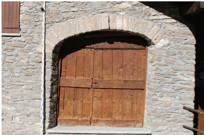
*Dettaglio del portone e del relativo arco in conci di tufo, reinserito nell'edificio ristrutturato.*
