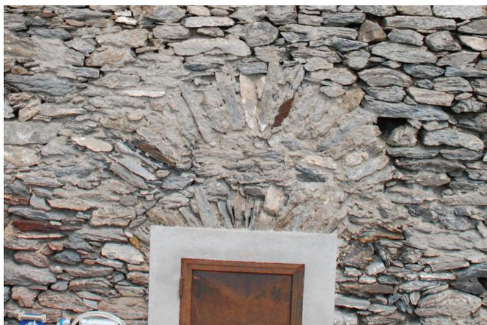
Fronte Sud, dettaglio di un'apertura, con arco di scarico e arco in conci di pietra. Cornice in cemento e serramento metallico.
