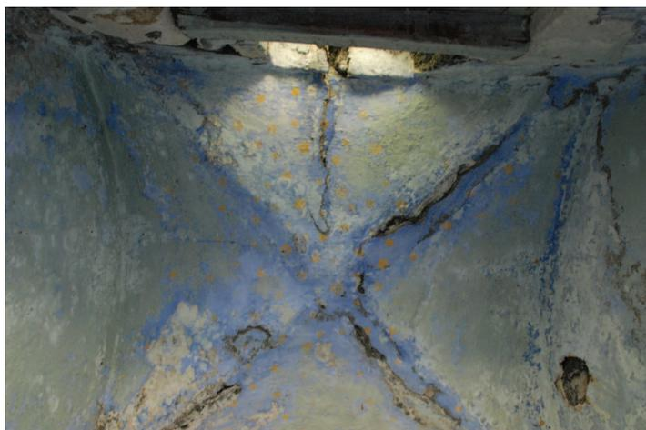
Dettaglio della volta a crociera presente all'interno della cappella, intonaco azzurro con stelle.
