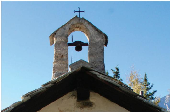
Dettaglio del campanile a vela. Si intravede una scritta illeggibile al di sotto del trave di colmo.
