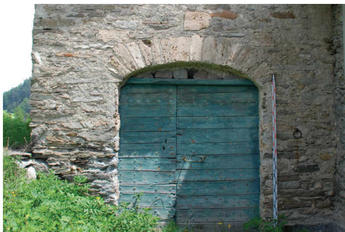
Dettaglio del portone ligneo di colore azzurro con arco in conci di pietra sul fronte Sud.
