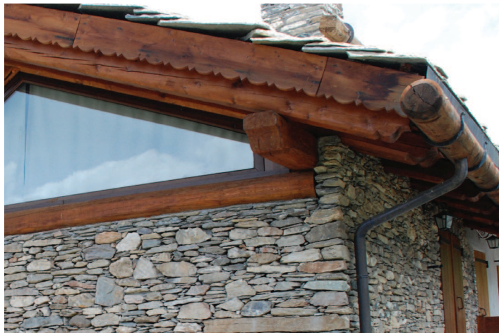
Dettaglio del rivestimento murario in pietra, copertura in legno e lose, finestra con telaio in legno e vetro.
