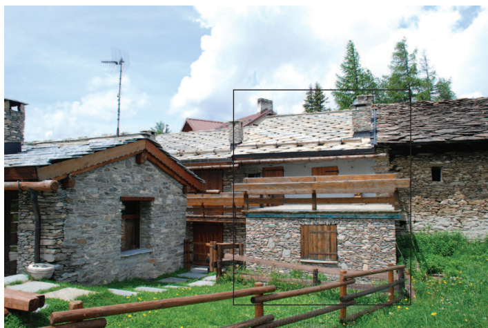
Immagine dell'edificio contestualizzato, prospetto sud - est.
