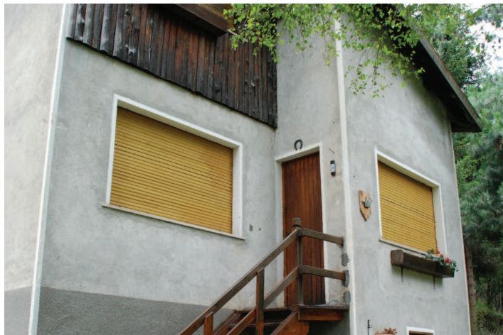
Dettaglio delle aperture, intonaco e parziale rivestimento ligneo di una parete.
