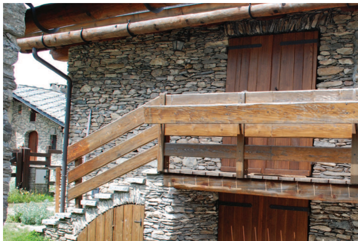
Dettaglio del rivestimento murario in pietra, arc o e piattabanda in conci di pietra, scala rivestita in muratura e ballatoio in legno. Serramenti lignei con cardini metallici.
