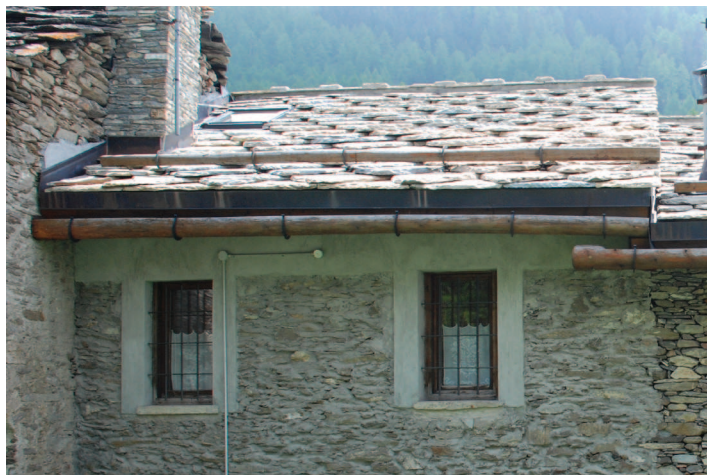
Vista del fronte Nord - Ovest, rinzafo e cornice in cemento, manto di copertura in lose con velux.
