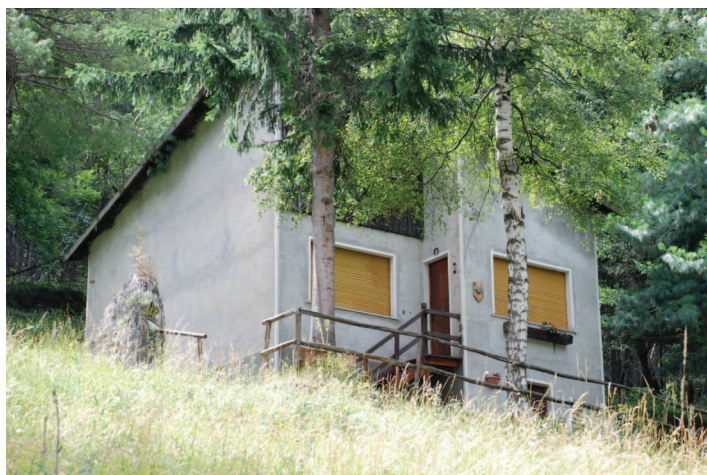
Immagine dell'edificio contestualizzato, vista da valle.
