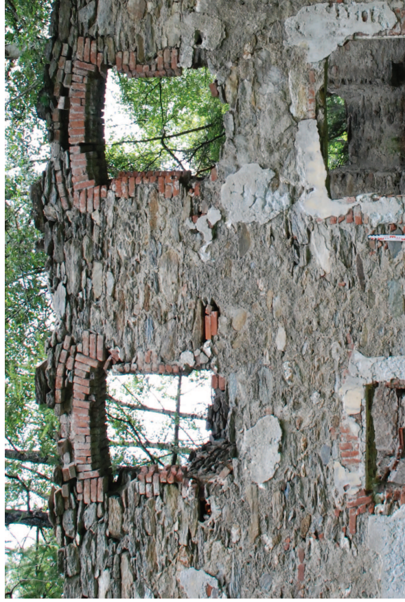
Rudere n.2, dettaglio delle aperture in mattoni della facciata.
