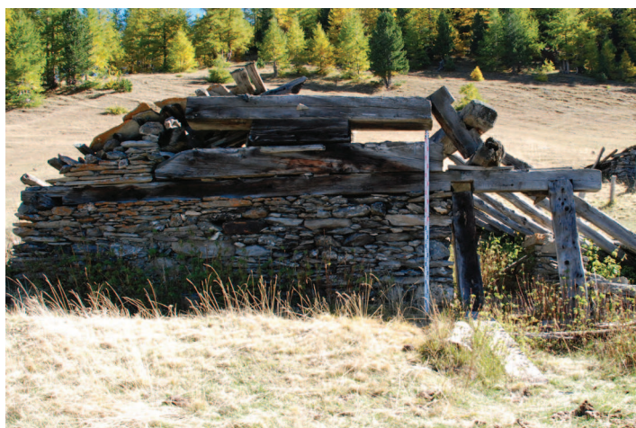
Dettaglio del prospetto verso valle, che presenta diverse travi a partire dall'imposta del timpano.
