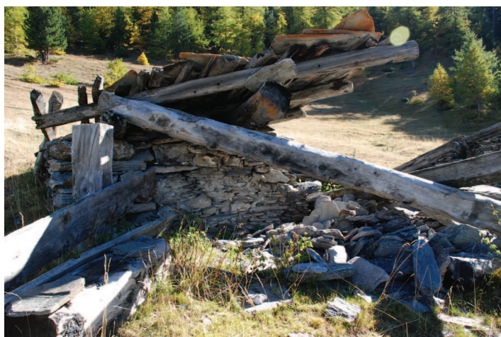
Resti della copertura e muratura in parte a secco ed in parte legata con malta.
