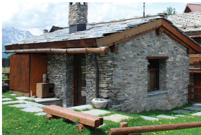
Differenza tra le due pareti, sulla destra malta cementizia a vista. Finestra con architrave ligneo e porta con vetro parzialmente riflettente.
