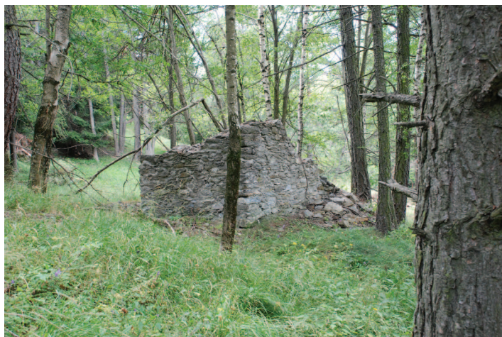
Rudere n.3, vista dal rudere n.2, muratura in pietra e malta.
