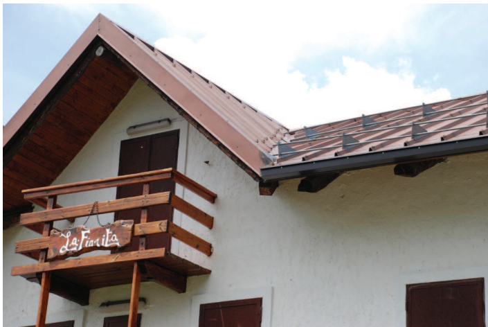
Dettaglio della copertura con manto in lamiera, intonaco bianco e cornici in cementizie dei serramenti metallici.
