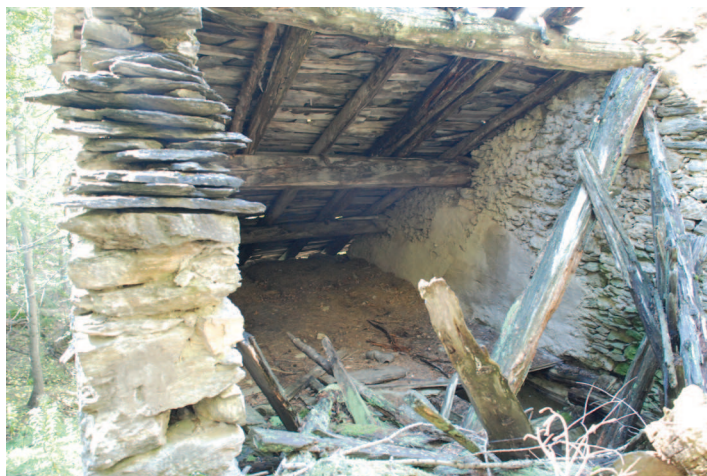
Vista interna della copertura con orditura lignea e manto in lose. Da notare l'utilizzo dei pioli in legno per fissare le lose.
