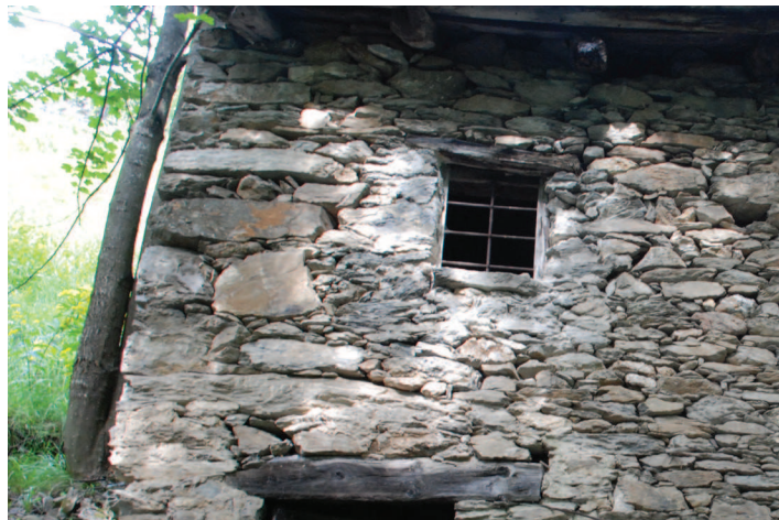
Dettaglio delle pietre da cantone, finestra con grata in ferro, porta e finestra con architrave ligneo.
