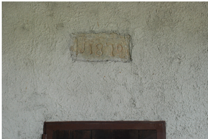
Incisione su pietra recante la scritta J 1870, blocco nord, fronte strada. In basso serramento metallico rivestito in legno.
