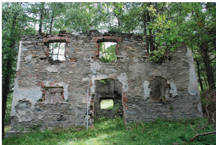
Rudere n.2, vista frontale, da notare le aperture con struttura in mattoni.
