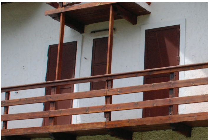
Dettaglio dei serramenti metallici e del ballatoio ligneo.
