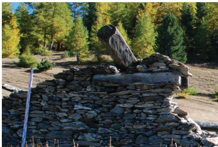
All'interno della muratura a secco sono stati inseriti travi in legno.
