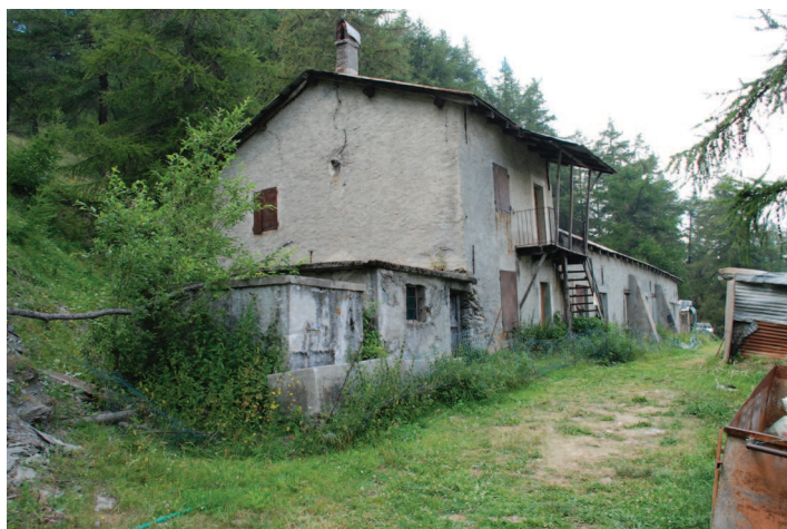
Immagine generale dell'edificio, vista da Est, sulla destra strutture precarie in lamiera.
