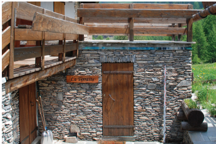
Dettaglio della terrazza, dei serramenti con anta lignea e paramento esterno della muratura in pietra. Sulla sinistra ballatoio in legno e intonaco bianco.
