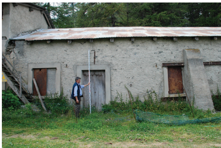
Fronte verso valle, si notano gli scuri metallici delle finestre e la porta in legno, entrambe con cornice in cemento. Sulla destra contrafforte in c.a. e putrelle metalliche.
