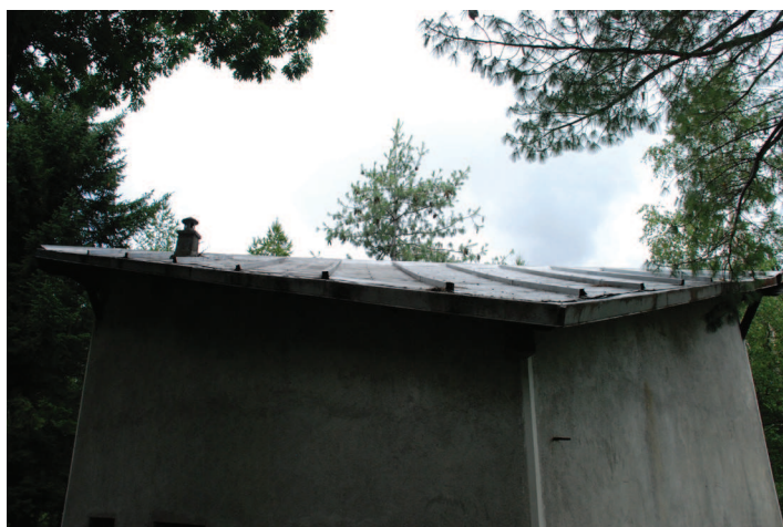
Copertura con orditura lignea e manto in lamiera, da notare l'orientamento inusuale del colmo.
