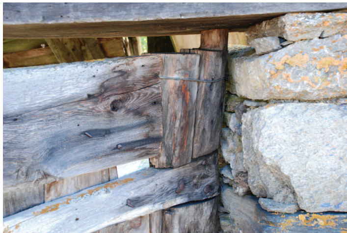
Dettaglio del cardine in legno della porta presente sul prospetto Nord.
