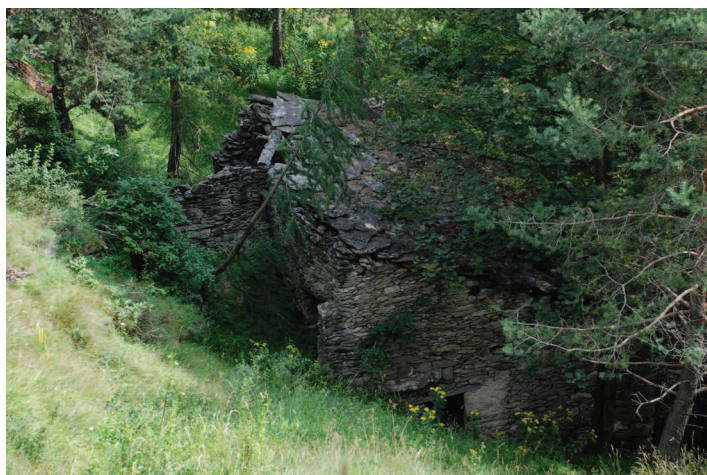
Immagine dell'edificio contestualizzato, vista da monte.
