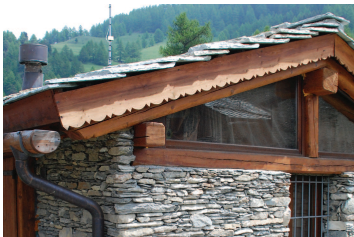
Dettaglio della copertura e del rivestimento murario in pietra. Finestra con telaio in legno e grande vetrata.
