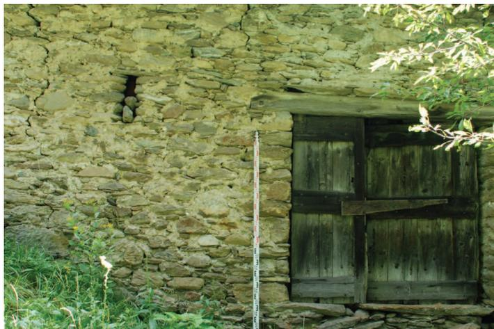
Dettaglio del portone ed architrave lignei e fessurazioni verticali, fronte Ovest.
