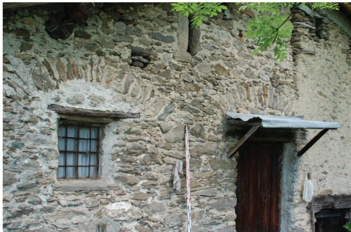
Dettaglio delle aperture con archi di scarico in conci di pietra, fronte Ovest.
