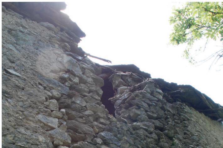
*Dettaglio del parziale collasso della muratura e di un parte di copertura.*
