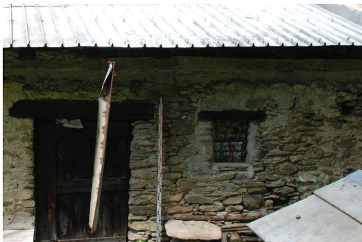
Dettaglio della facciata, si evidenzia in particolare il cordolo in c.a., gli architravi ed il portone lignei ed il rinforzo con malta cementizia nei pressi della finestra.
