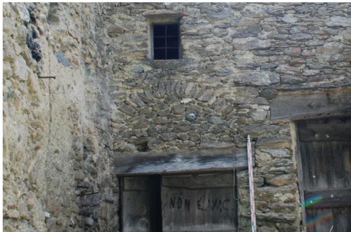
Dettaglio dell'arco di scarico in conci di pietra sopra architrave ligneo, fronte Est.
