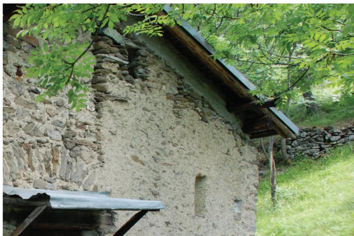
*Manto di copertura in lamiera, cordolo in c.a., muratura con rinforzo di malta di calce pigmentata con terriccio.*
