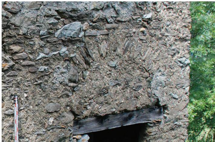
*Dettaglio dell'arco di scarico in conci in pietra al di sopra dell'architrave ligneo della porta.*
