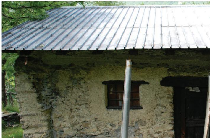
*Manto di copertura in lamiera, gronde staccate, cordolo in c.a., uso di malta cementizia in facciata, finestra con architrave ligneo grata in ferro.*
