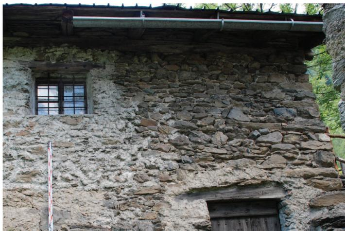
Dettaglio della copertura con manto in lamiera, architrave e porta lignea, finestra con vetro e grata in ferro.
