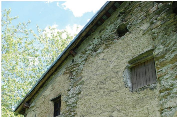
Dettaglio della copertura con manto in lamiera e del cordolo in c.a.. Si noti anche il rinforzo in malta pigmentata con terriccio. Fronte Est.
