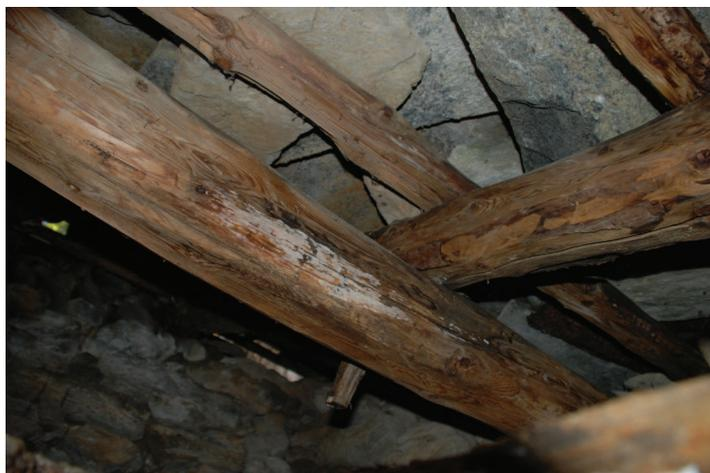
*Dettaglio della copertura vista dall'interno, si noti l'uso di pioli in legno per il fissaggio delle lose e dell'orditura lignea.*
