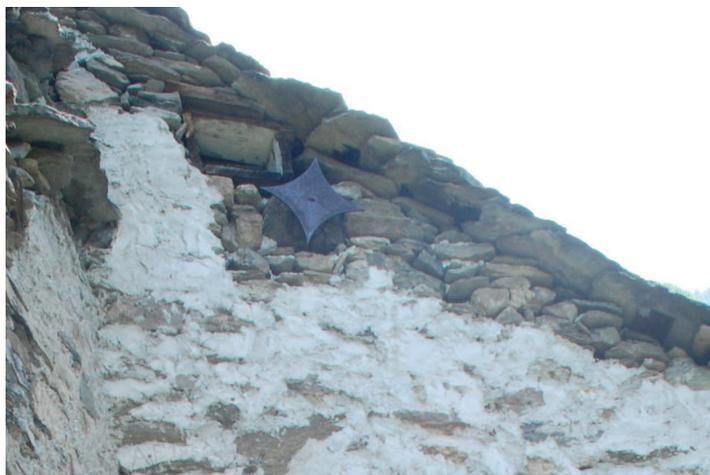
*Fronte Nord - Ovest, piccola apertura per l'aerazione del sottotetto e protezione in ferro sagomata per la trave.*
