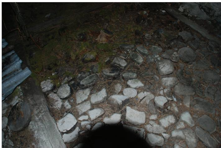
Interno della stalla, pavimentazione realizzata con tronchi inseriti di testa nel terreno.
