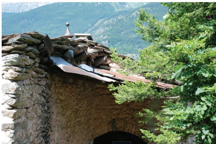
*Dettaglio della copertura provvisoria in legno e lamiera ondulata a protezione del portone.*
