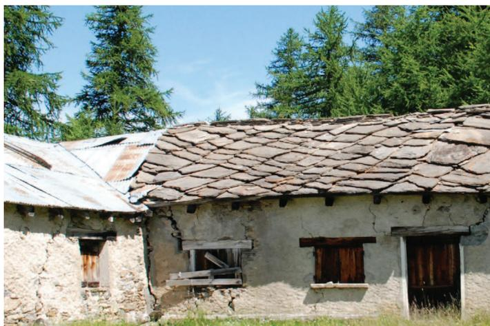
Dettaglio del punto di giunzione tra le due tipologie di manto di copertura. Serramenti ed architravi lignei.
