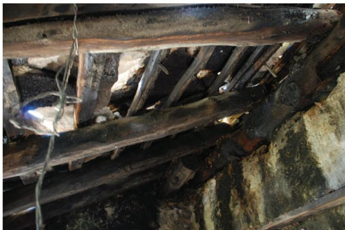
Vista della copertura dall'interno, si noti l'uso di pioli in legno per il fissaggio delle lose.
