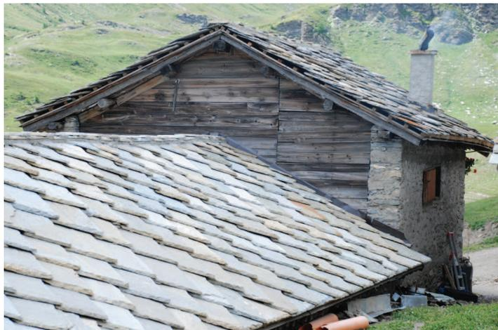
Dettaglio di parete costituita da assi in legno e manto in lose recentemente ristrutturato.
