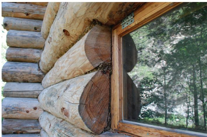
Dettaglio di una parete, si nota la struttura blockbau a tronchi sovrapposti, con uso di muschio come isolante tra un tronco e l'altro. Serramento ligneo.
