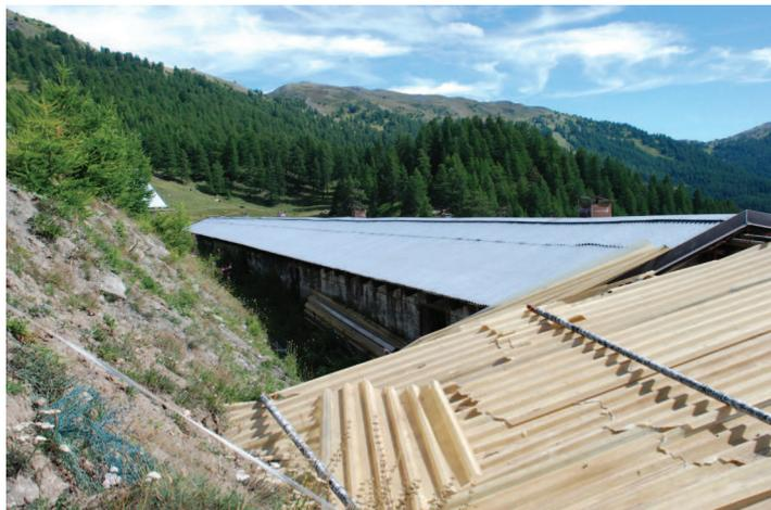
*Prospetto Nord della stalla, si noti la copertura ondulata in vetroresina in primo piano e la copertura della stalla in lamiera.*
