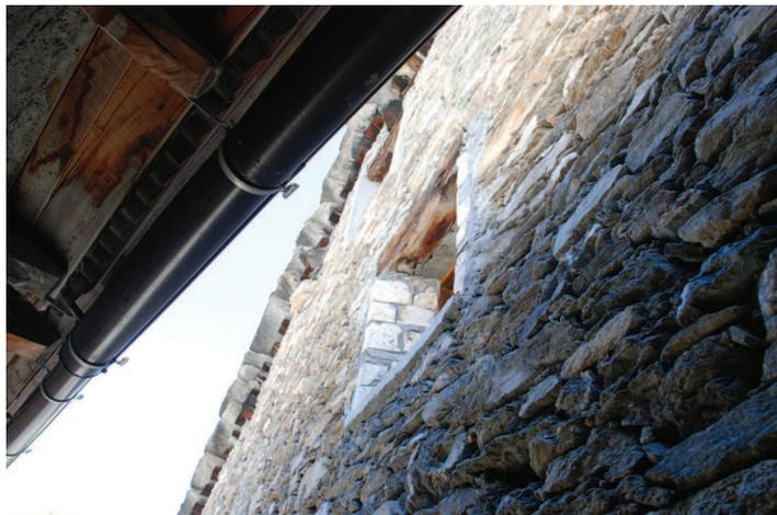
Dettaglio di finestra con strombatura rifinita con pietre di diverso tipo e malta cementizia.
