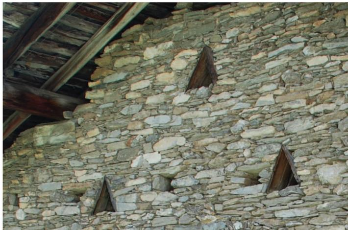
Dettaglio delle caratteristiche aperture triangolari per l'aerazione del granaio.
