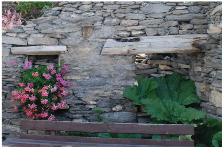
Fronte Ovest, dettaglio delle due aperture con architrave ligneo.
